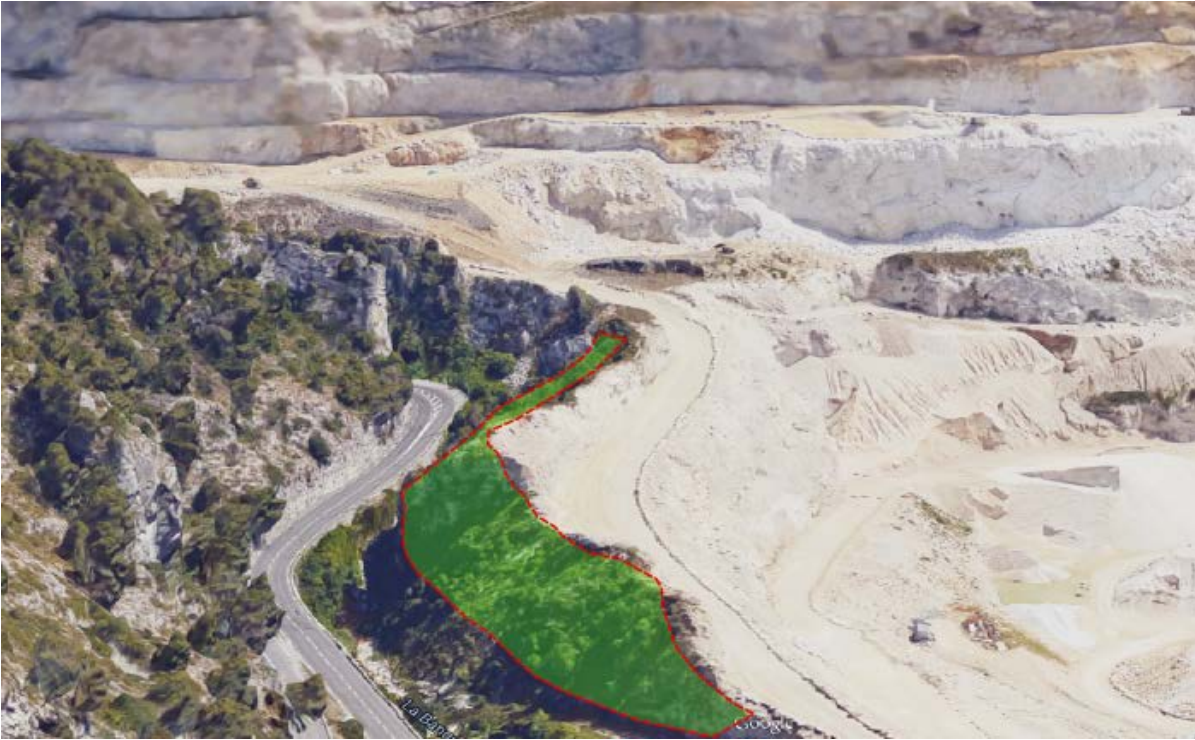
Conservation des talus en éboulis rocheux entre la carrière et la Banquière afin de conserver la physionomie de gorges du secteur. Source : Google © - ECOTER, 2015
